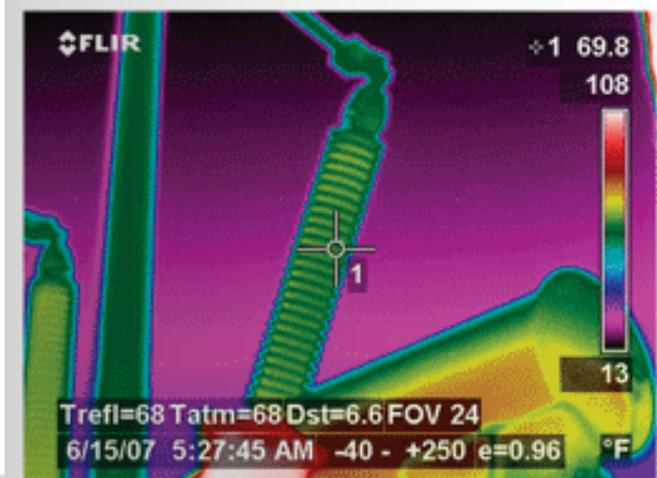
La imagen térmica del manguito aislador de la fase A y la conexión de entrada en su paso en el transformador de 161KV a 13,8KV no muestra aparentes puntos calientes.
